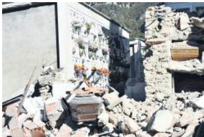
Sopra: Il terremoto non ha risparmiato neppure il cimitero di Norcia dove sono crollati loculi e cappelle funebri.
